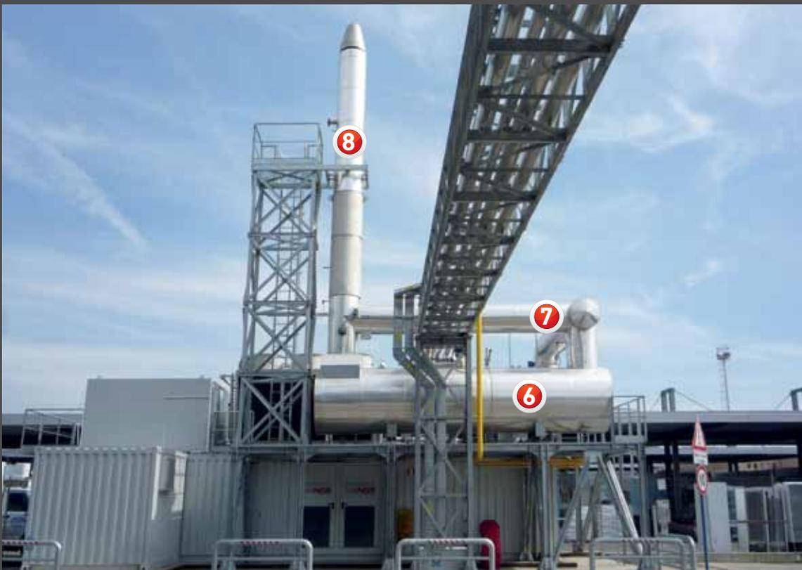
**6 Caldera de recuperación de humos:** para la producción de agua caliente, vapor o aceite diatérmico, mediante la recuperación de los humos de escape.
